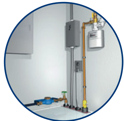
Mehrspartenhauseinführung in der Haushaltsinstallation
